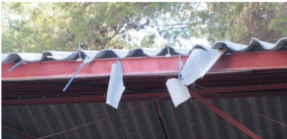
Les plaques à base de ciment utilisées pour les couvertures sont renforcées par des fibres. Certaines l'étaient avec des fibres d'amiante jusqu'en 1997. Ces plaques, bien que très semblables à celles d'aujourd'hui, méritent une attention particulière lors des interventions car, outre leur fragilité, elles présentent donc un danger lié à l'amiante qu'elles contiennent.
